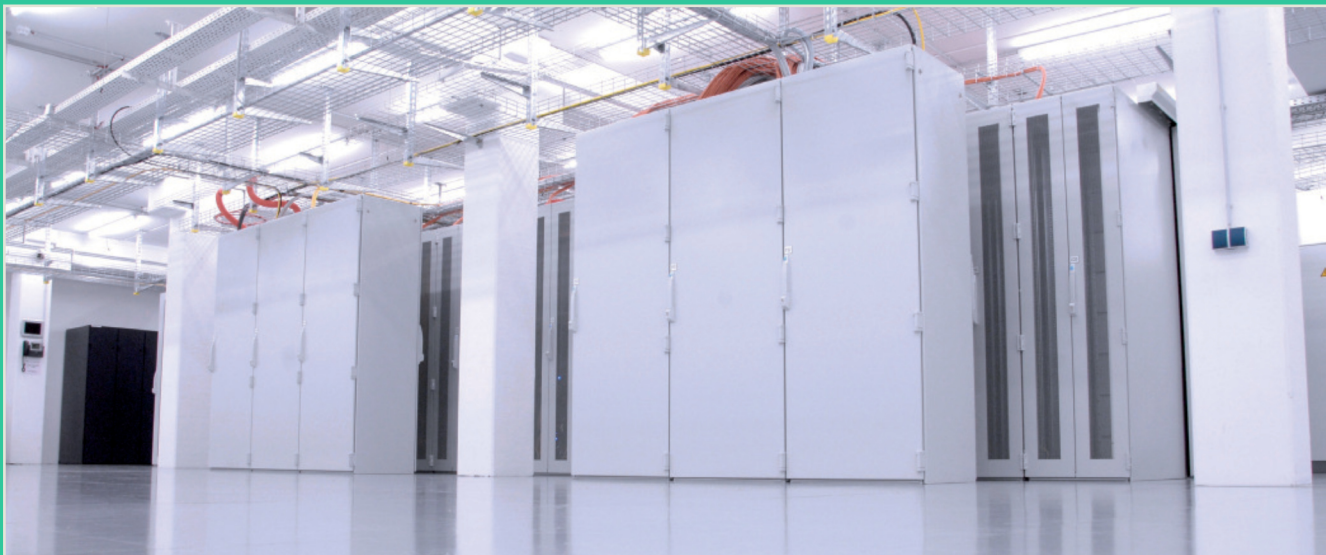
Belüftete Kundenracks (Rückseite) mit oben liegenden getrennten Faser- und Kupferkabeltrassen. Zentrale MMR/ODF-Racks (Vorderseite).
