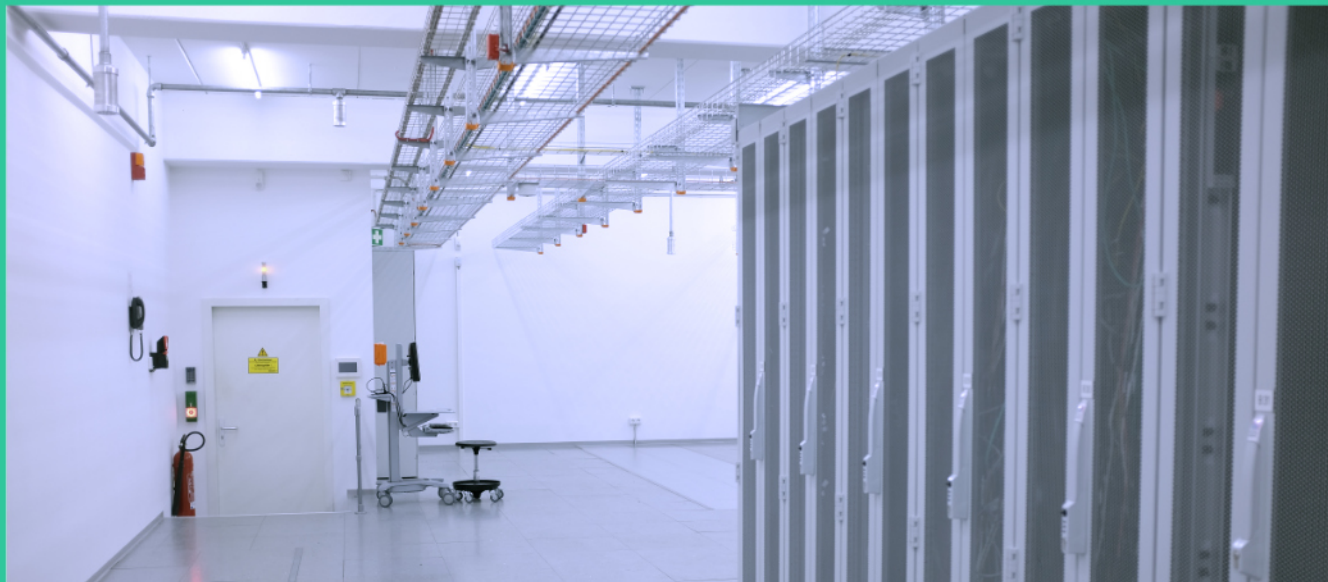
Belüftete Kundenracks (Rückseite) mit oben liegenden getrennten Faser- und Kupferkabeltrassen. Zentrale MMR/ODF-Racks (Vorderseite).
